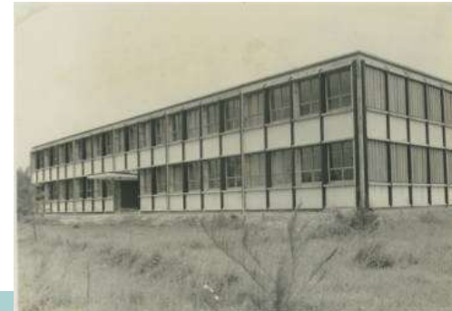
1960年興建完成的核子工程館
